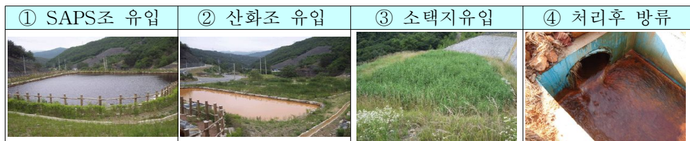
<그림 11> 산성광산배수의 자연정화 처리 현장
