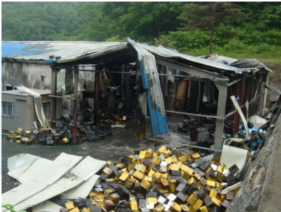
Fig 2.1 유사휘발유 제조 중 사고 발생 현장 [4]
