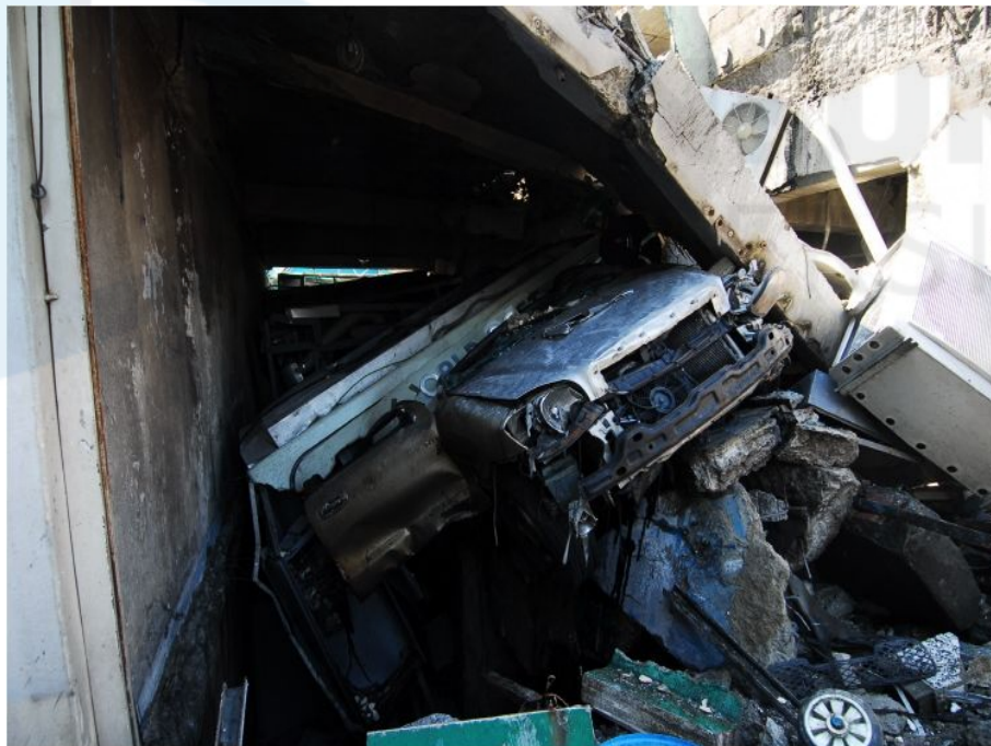
Fig 2.4 유사휘발유 보관 중 주유소 사고 현장(후면) [5]
