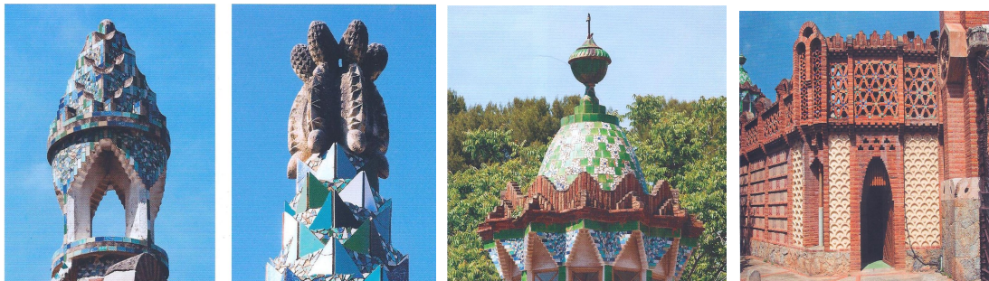
<그림3.13>구엘 별장 굴뚝과 환기구 <그림3.14>구엘 별장 채광탑 <그림3.15>구엘 별장외관 출처: 신은 기다리지 않는다. 가우디
