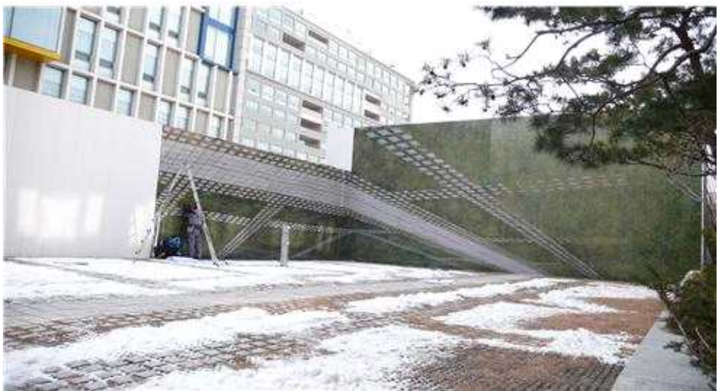
그림 44 < 아트펜스 부착 시공, 2015 >
