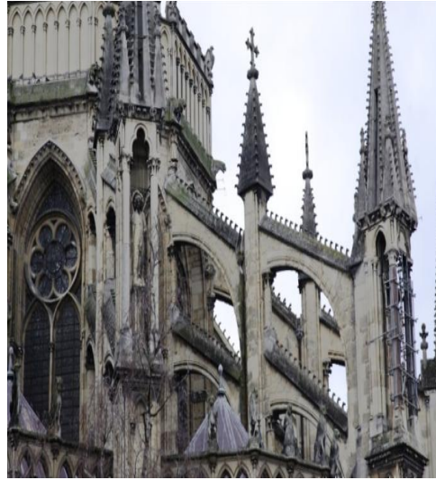
<그림 2> 플라잉 버트레스(Flying buttress)
