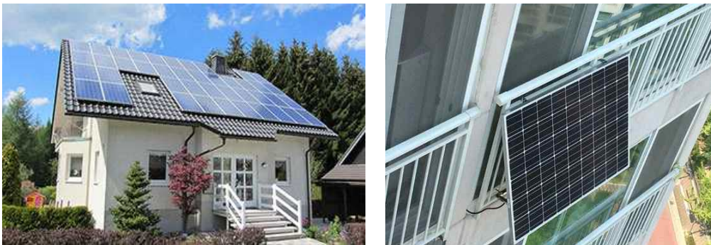
[그림 2-6] 가정용 태양광 발전 설비 모습
