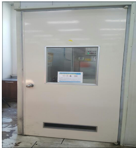
[그림 7] 세척작업장 밀폐를 위해 설치된 방화문.
