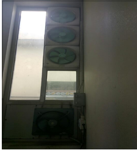
[그림 6] 세척작업장 내부 전체환기 설비.
