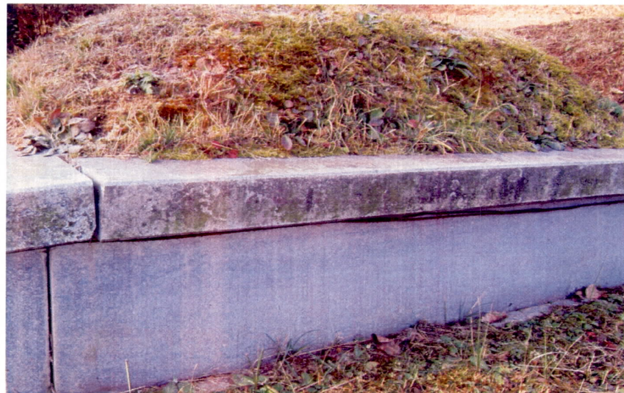
[그림73] 수맥으로 인하여 묘테석을 철사로 동여 멘 모습
